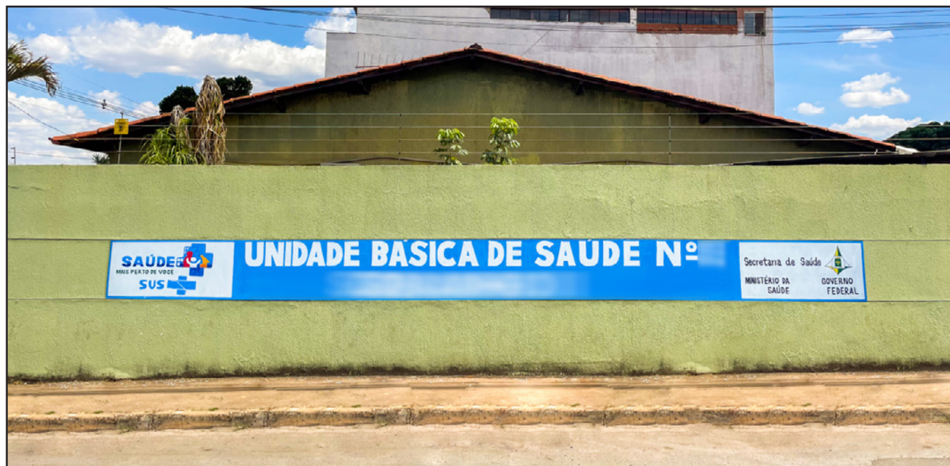
Figura 2 – Fachada externa: pintura da identificação nominal da UBS.
